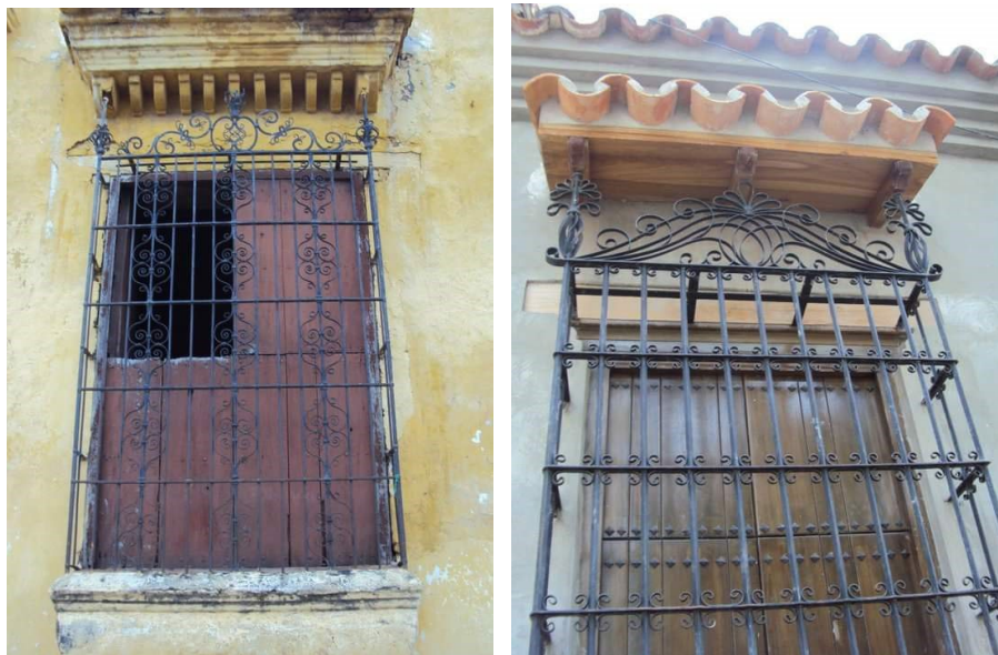
Figura 13. Larios, P. Muestras de ventanas en forja en el municipio de Mompóx [Fotografía].
