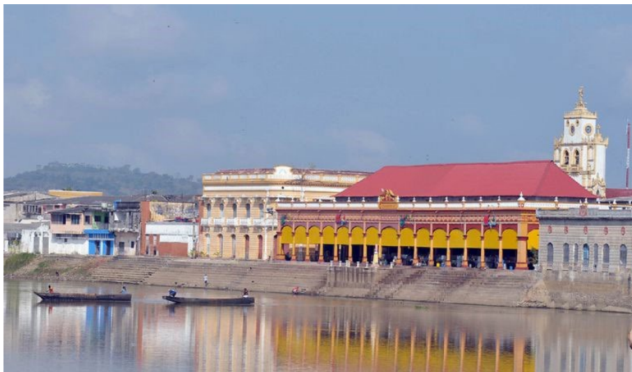
Figura 18. Edificio del Mercado Público en Lorica [Fotografía].
