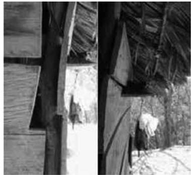
**Imagen 25. Detalle del empalme de muros de cerramiento en tabla, apoyados sobre horcones en madera rolliza**
