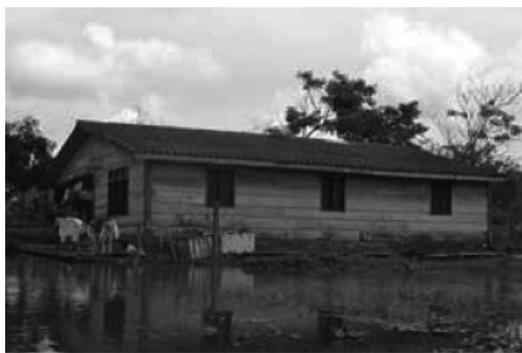
**Imagen 24. Vivienda sobre estructura de pilotes en madera en Trojas de Cataca**
