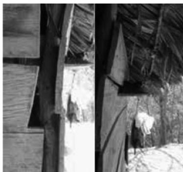
**Imagen 25. Detalle del empalme de muros de cerramiento en tabla, apoyados sobre horcones en madera rolliza**
