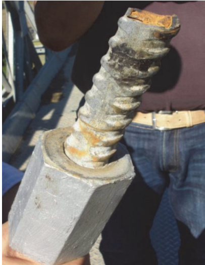
Figura 6.3. Varilla del pendolón fracturada
