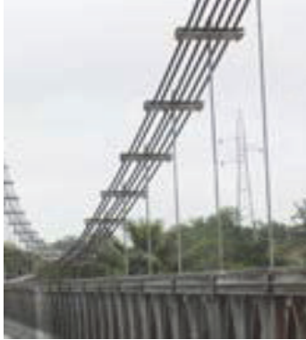
Figura 4.13. Cables del puente de Campo Dos
