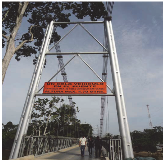
Figura 3.4. Vista de frente del puente
