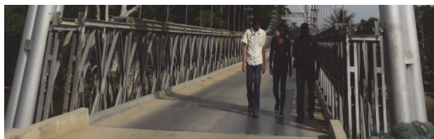
Figura 3.8. Calzada del puente de Campo Dos
