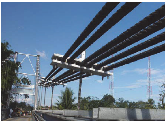
Figura 1.3. Herraje de un pendolón
