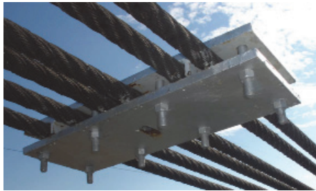
Figura 7.1. Herraje del pendolón fracturado
