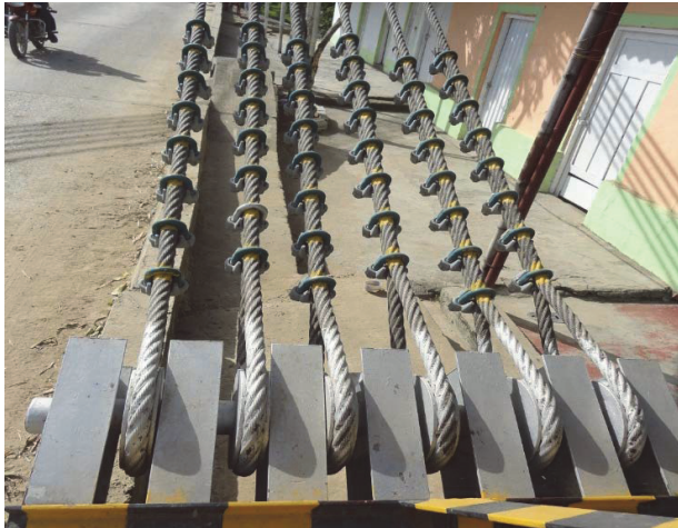
Figura 3.1. Cables asegurados a la torre de anclaje
