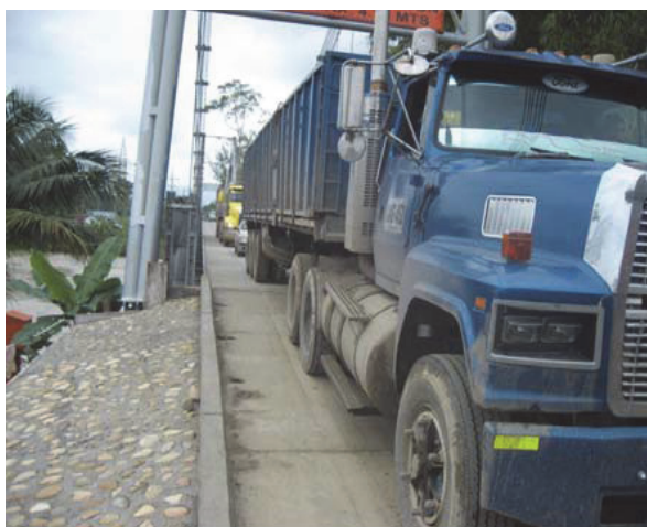
Figura 5.3. Exceso de carga sobre el puente de Campo Dos
