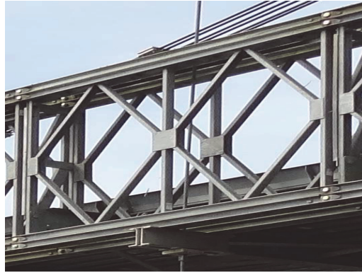
Figura 3.5. Vista lateral de la estructura del puente
