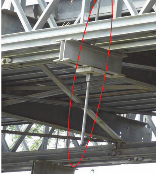
Figura 1.2. Pendolón en la parte inferior
