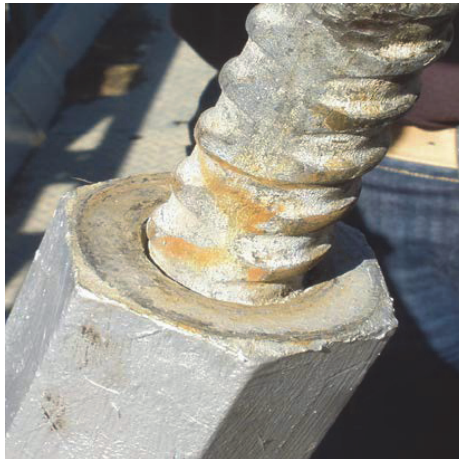
Figura 6.1. Estructura geométrica de la varilla del pendolón
