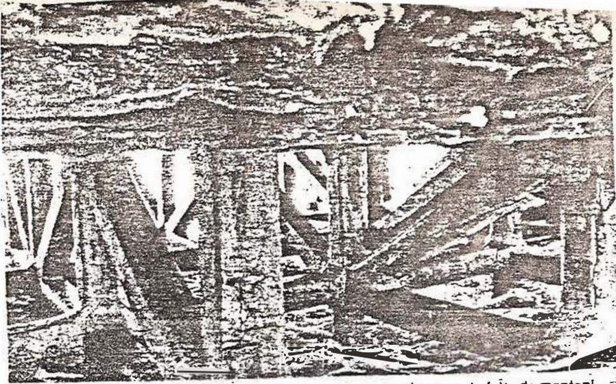
Totamente fracturadas, afectadas por la acción de las olas y por la falta de mantenimiento, están las columnas de soporte del muelle de Puerto Colombia [Arrieta]
