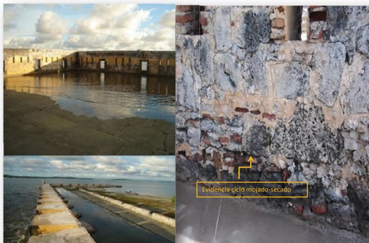
**Imagen 4. Ciclos de mojado-secado por efectos de marea alta y patología generada.**
