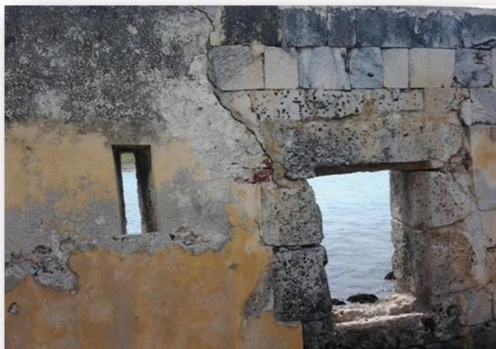
**Imagen 5. Sección de muro original y sección de muro restaurado**
