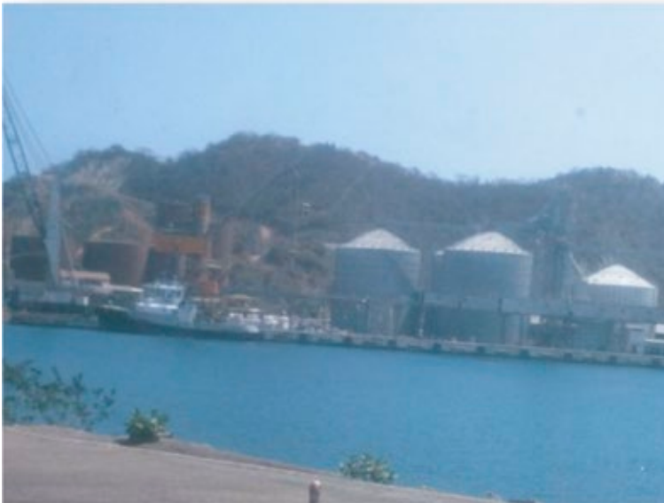
Fotografía 2. Silos de almacenamiento de carga
